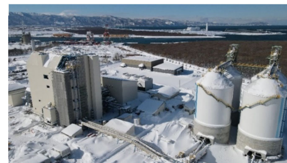
建設中のバイオマス発電所(石狩バイオエナジー合同会社提供)
