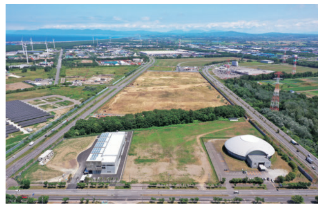
▲造成が進む花畔(ばんなぐろ) 第二4工区用地
