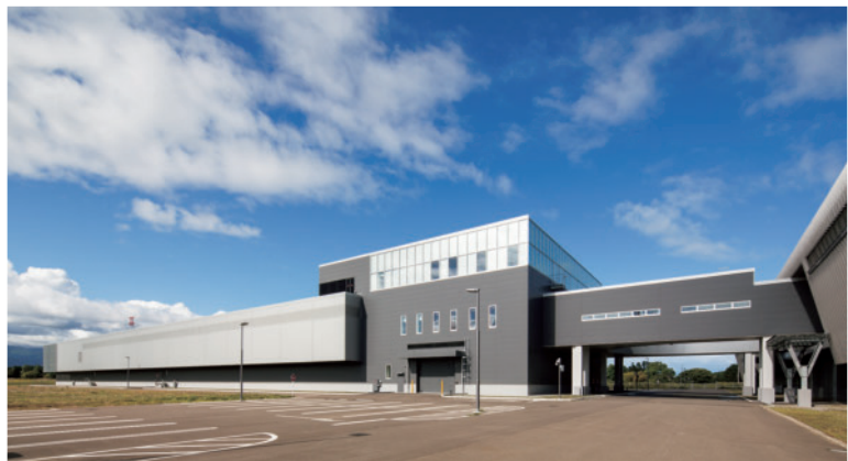
▲さくらインターネット石狩IDCセンター
