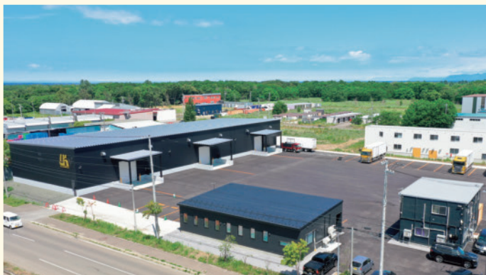
▲増築した本社営業所
